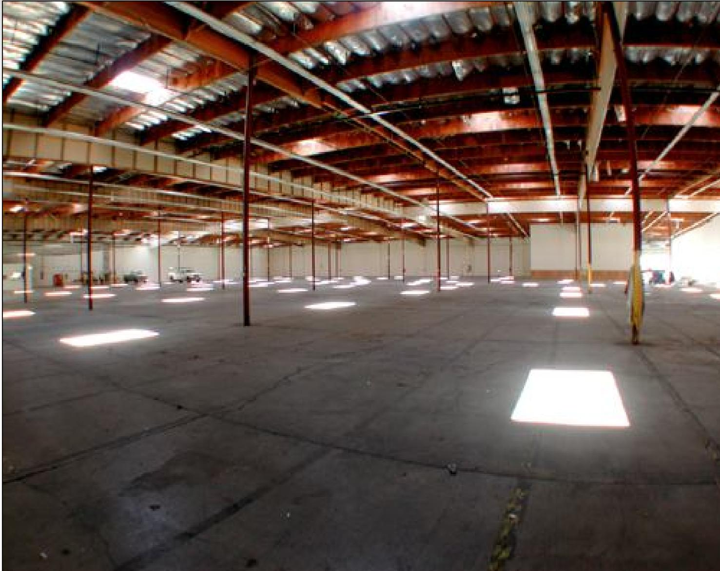
La apertura de huecos en la envolvente tiene un coeficiente de transmitancia de luz visible máximo, pero no consigue difusión
